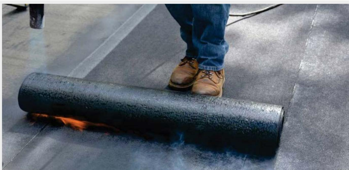
Aplicação de manta asfáltica a maçarico
