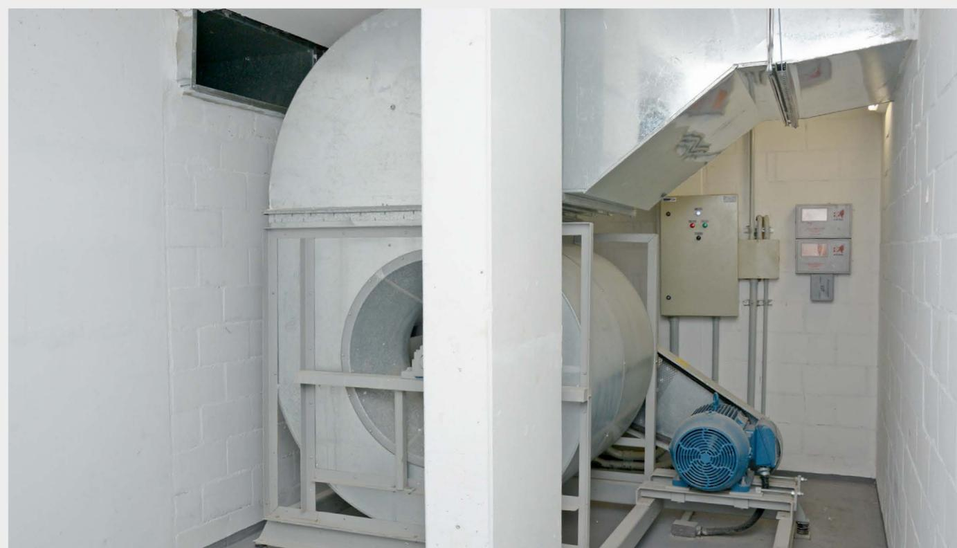
Motor, ventilador, dutos e quadro de comando de pressurização de escadas
