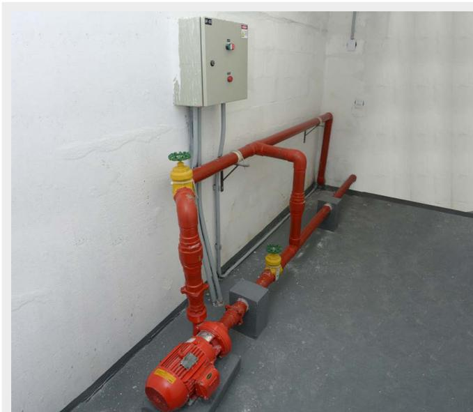
Conjunto motobomba de água de combate à incêndio e quadro de comando
