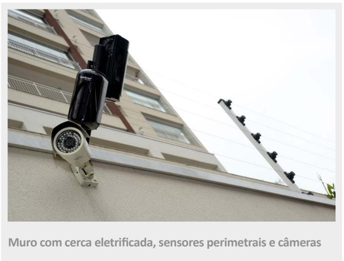
Muro com cerca eletrificada, sensores perimetrais e câmeras
