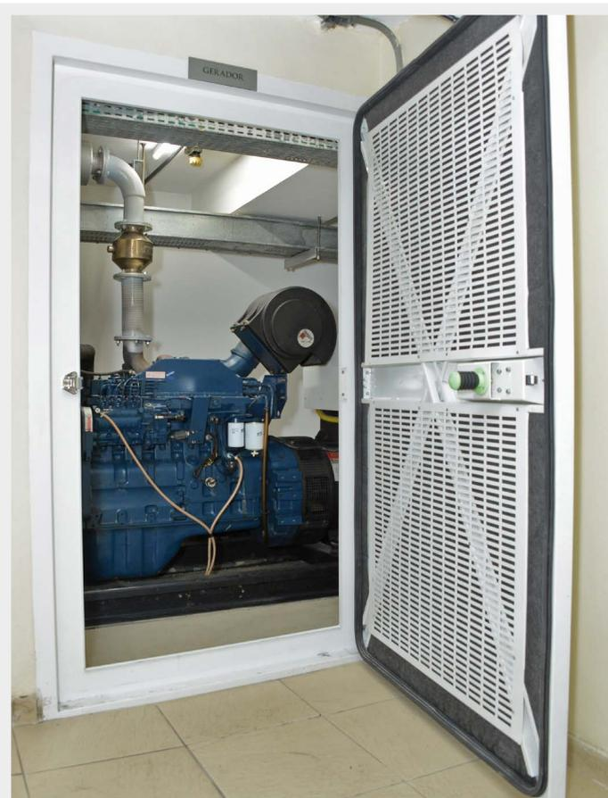
Abrijo de gerador e detalhe da porta com isolamento acústico
