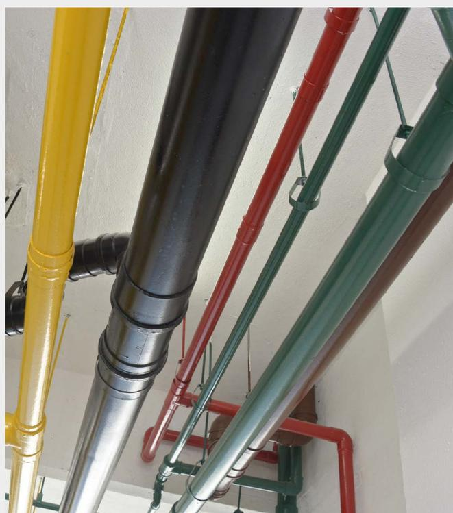
Tubulações aparentes de água (verde), água pluvial (marrom) esgoto (preto), água da reserva de combate à incêndio (vermelho) e gás (amarelo)
